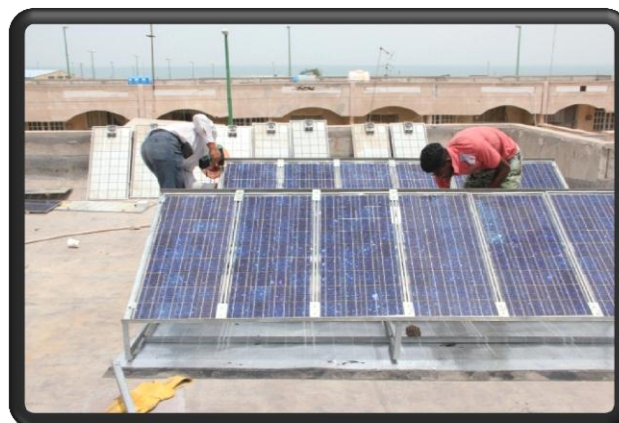
نصب پانلهای خورشیدی
