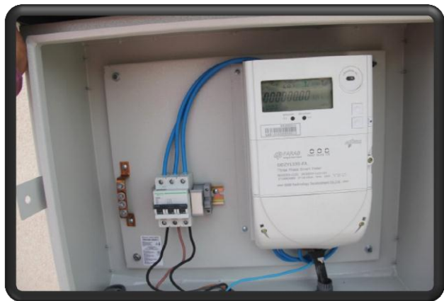
نصب کنتور هوشمند در ساختمانهای شماره 1 و 2 و 3
