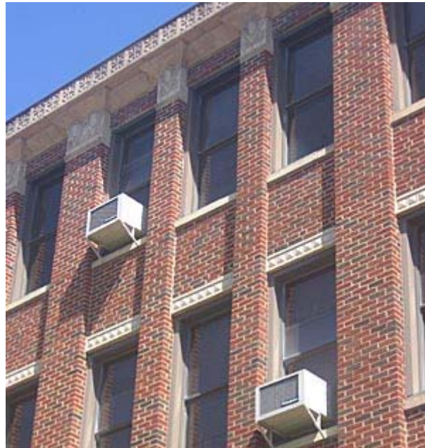
شکل ۶- نحوه استقرار کولرگازی پنجره ای
